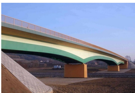
Most na rzece Wisłoka w miejscowości Jaworze Górne (fot. www.gddkia.gov.pl ).
